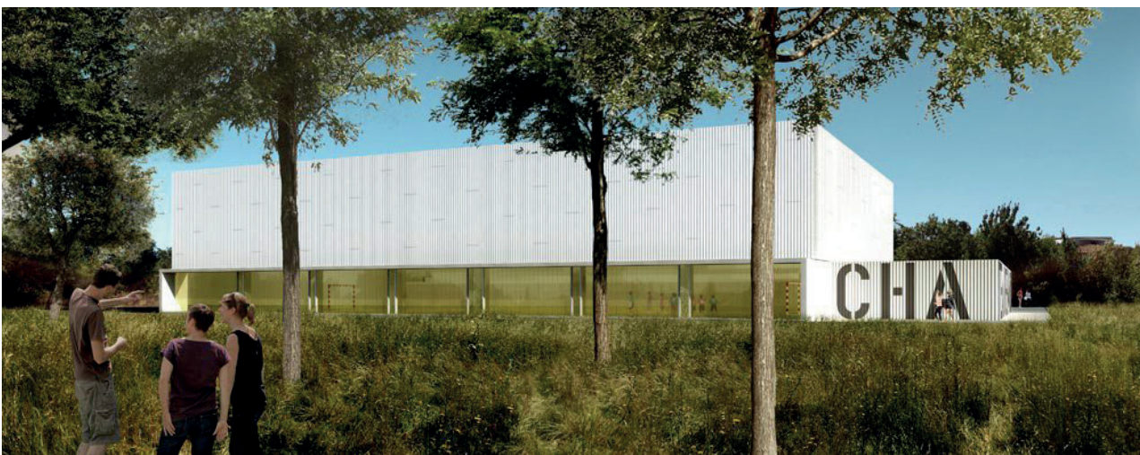
LYCÉE DE CHATEAURENARD / Construction Lauréat maîtrise d'œuvre : José MORALES Architecte et Rémy MARCIANO Architecte
